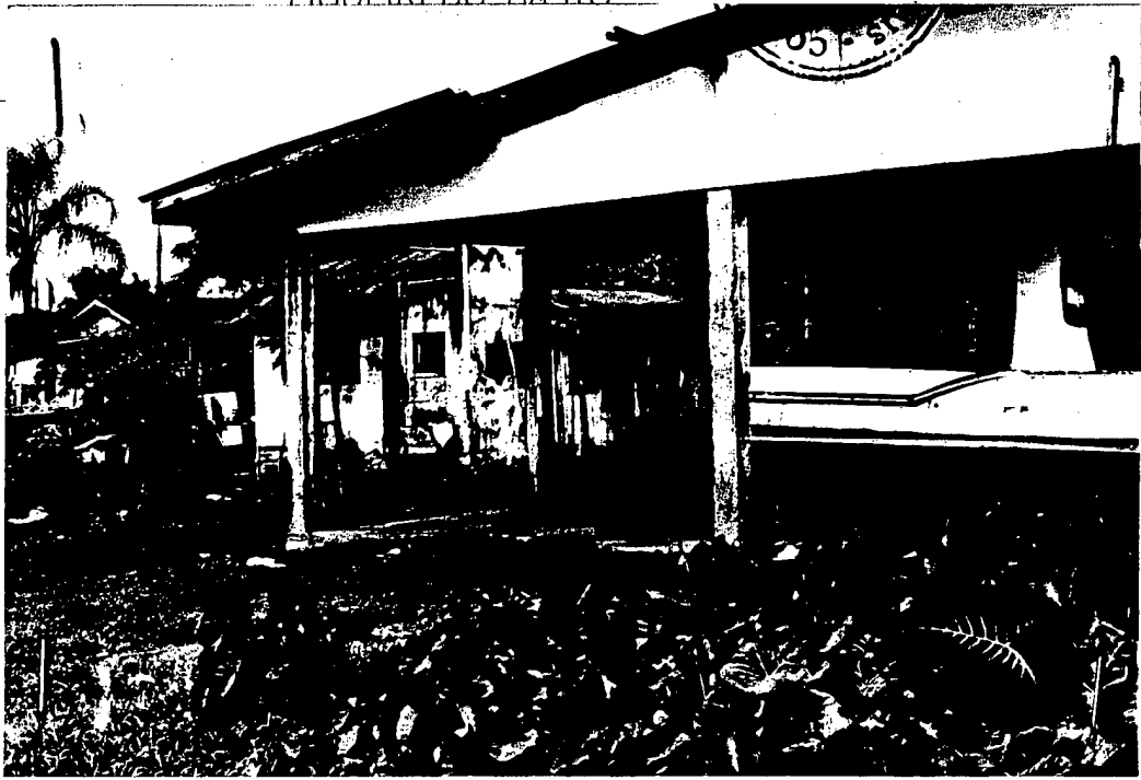
13 - FUNDOS BARRACÃO - CASA ROSA LEITE
