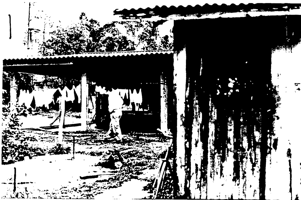
18 - FRONTO LATERAL DIREITA BARRACÃO FRONTO LATERAL ESQUERDA CASA DOS LEITE
