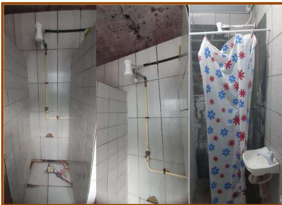
Figura 8 - Banheiros 1 e 2 Fotografados na UAI Boqueirão e Banheiro 3 Fotografado no Hotel Social da Conselheiro Araújo.
